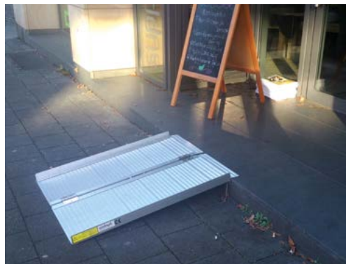
Abbildung 13: Beispiel für eine mobile Rampe (Quelle: NeumannConsult)
