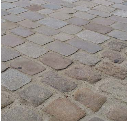
Abbildung 9: Abgeschliffenes Kopfsteinpflaster (Quelle: NeumannConsult)
