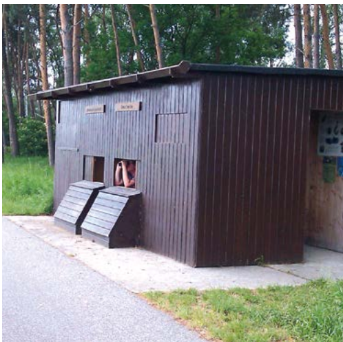
Abbildung 5: Bequem erreichbare Beobachtungshütte mit unterfahrbaren Sehschlitzen in Schwedt (Quelle: NeumannConsult)
