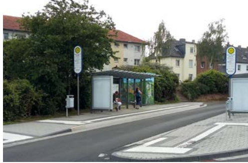
Abbildung 16: Bushaltestelle (Quelle: IBH Ingenieurbüro Hartmann, Bonn)
