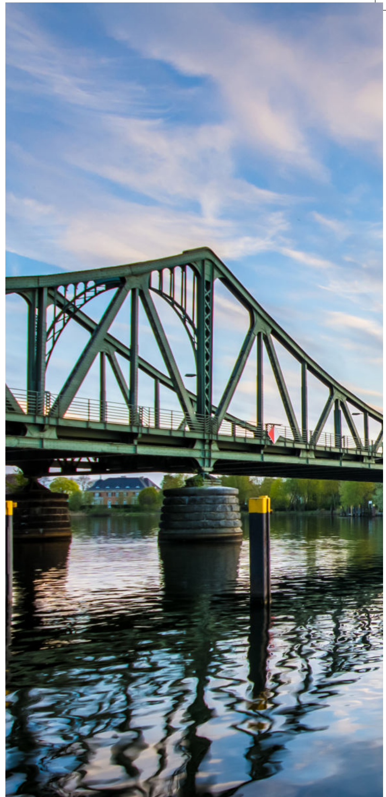
Blick auf die Glienicker Brücke
